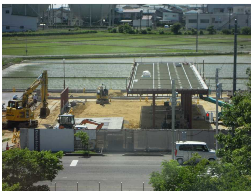
更に進んだ校舎正面ガソリンスタンド工事
